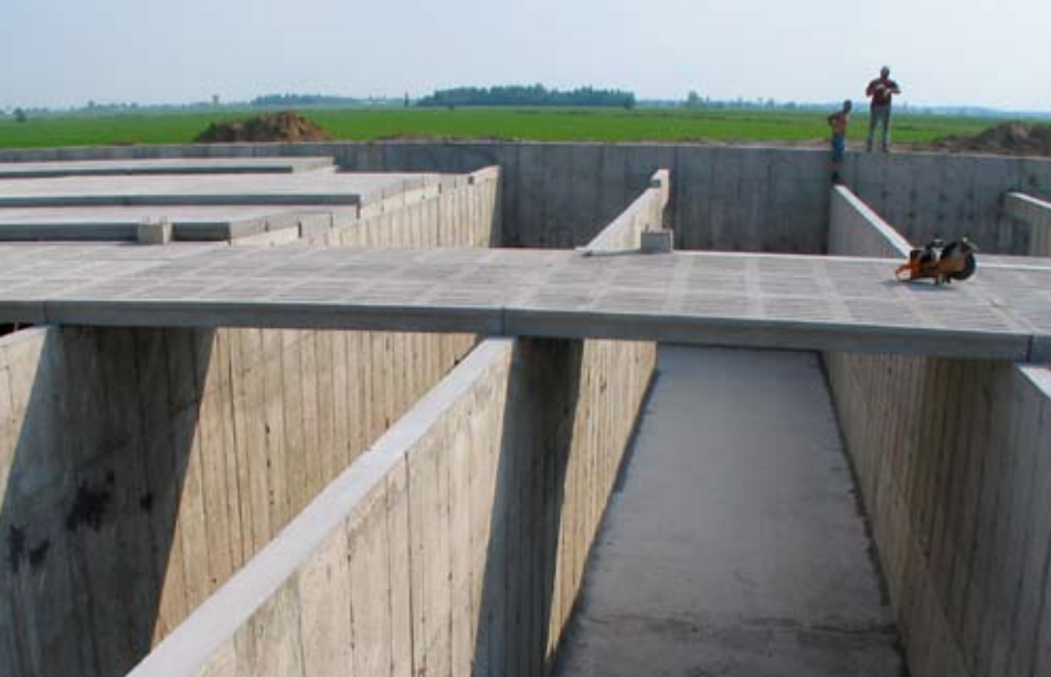
Système de serpentin en cours de construction : le quai d'agitation et le réseau de canaux et de passages permettent la circulation du lisier.
