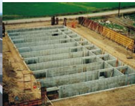
Système de serpentin en cours de construction : le quai d'agitation et le réseau de canaux et de passages permettent la circulation du lisier.
