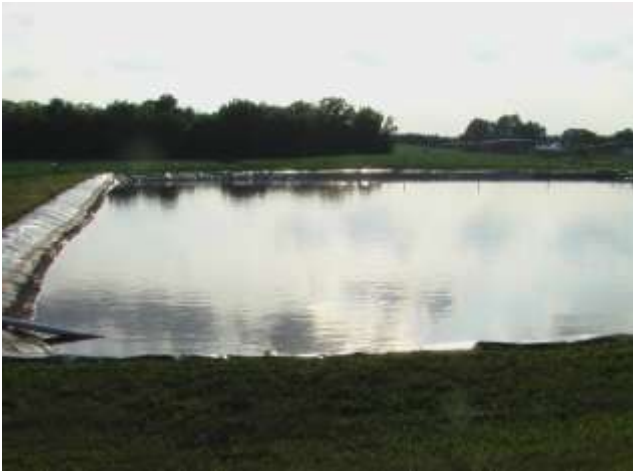
Lagune en sol et membrane étanche pour une ferme de 200 vaches laitières (Minnesota). Cette lagune sert à l'entreposage de tous les lixiviats, eaux de précipitation et eaux de laiterie.
