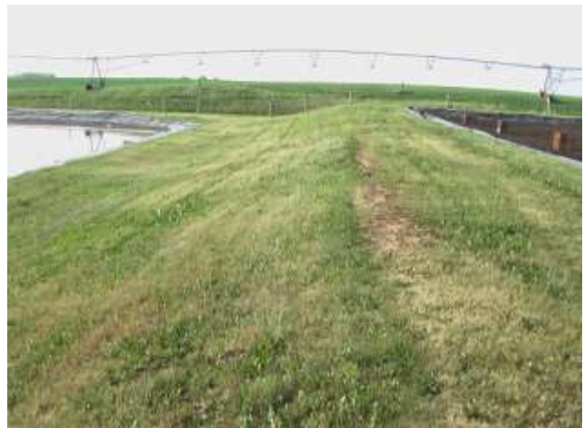
Aménagement du site pour un écoulement par gravitation des lixiviats entre le bassin de sédimentation et le purot. Les collecteurs sont localisés dans le bassin de sédimentation.
