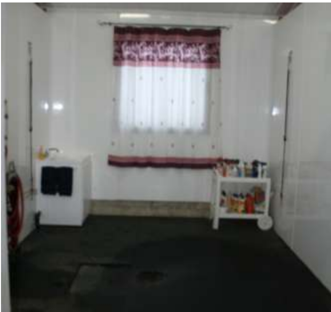
Aménagement de douche avec revêtement plastique
