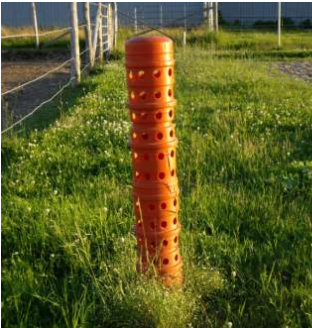
Un système d'avaloir pour les eaux de surface, relié au drainage souterrain, permet le contrôle efficace de la hauteur de la nappe d'eau.
