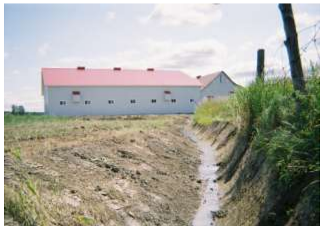
Les profondeurs des fossés doivent être déterminées selon les élévations du plancher de l'écurie, des chemins d'accès et du manège.
