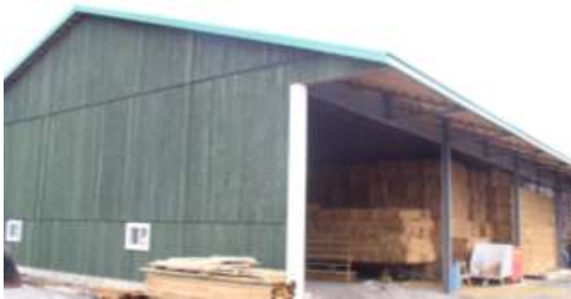
Entrepôt à foin à façade ouverte qui peut être fermée par une bache.
