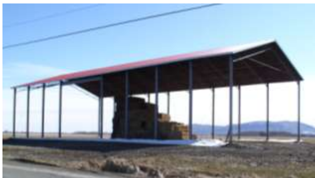
Entrepôt à foin entièrement ouvert.
