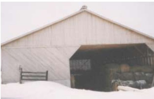
Entrepôt fermé, avec portes décentrées.
