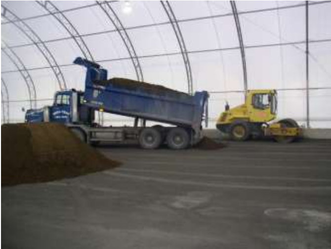
Camion déversant du sable sur une base compactée
